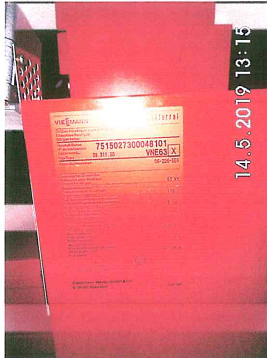
Bild 9340: Typenschild Heizkessel 63kW
