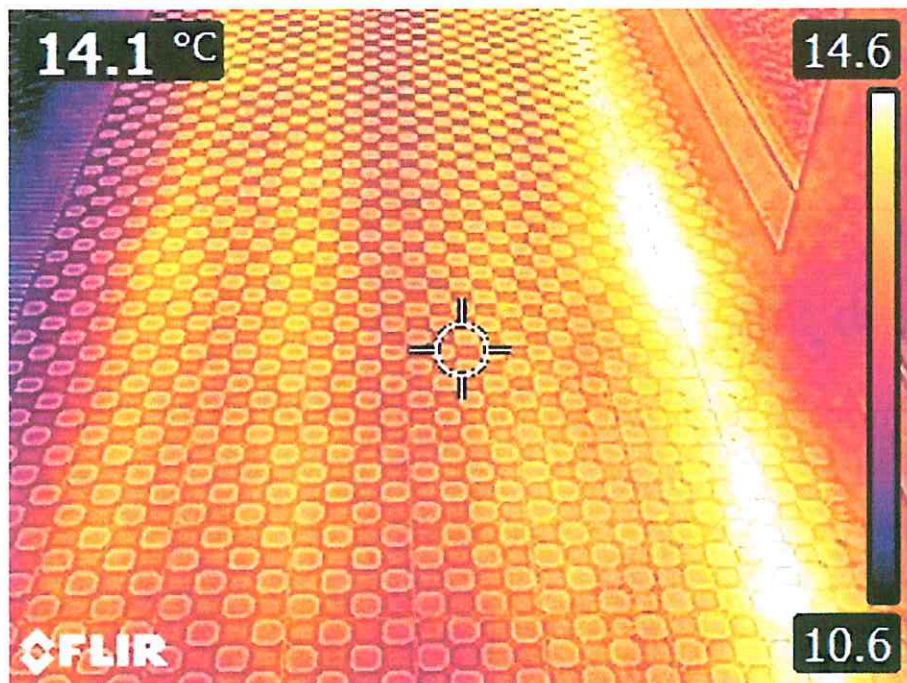
Bild 2722: Fußbodenfläche in der Schwimmhalle durch Fußbodenheizung beheizt
