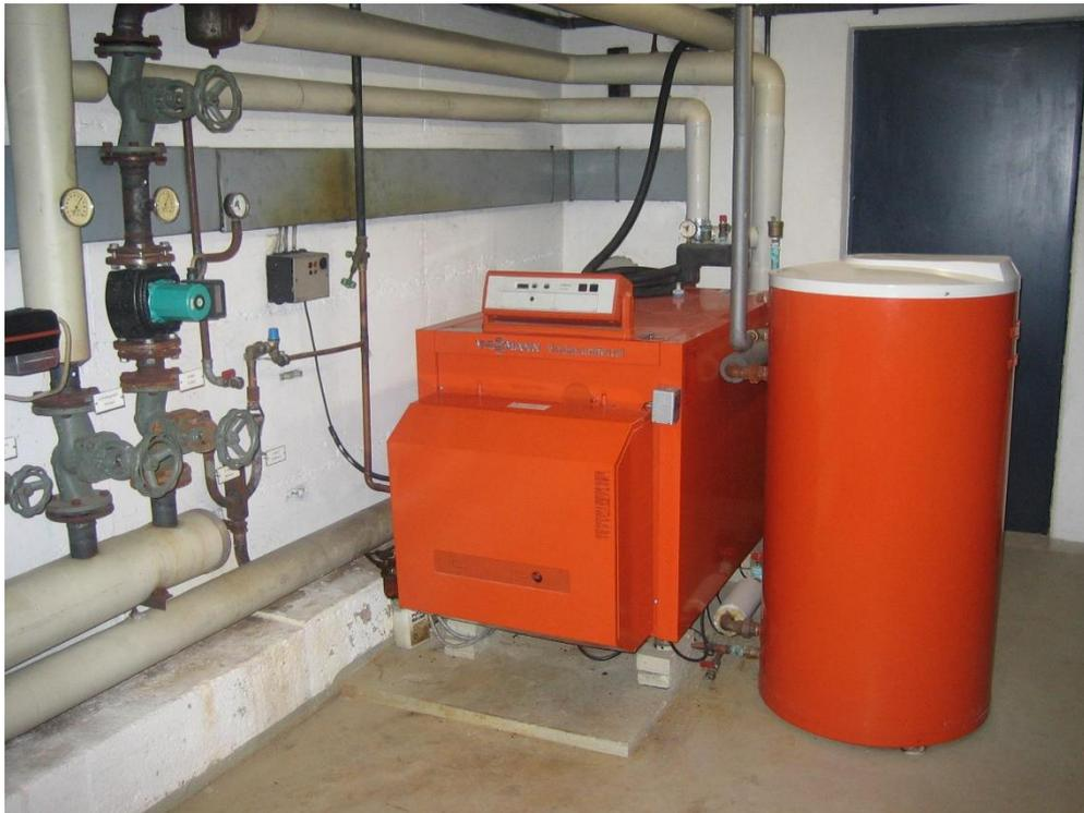
Die Firma Grones aus Kempenich hat dann im April 2012, also 1 ½ Jahre vor dem Auftauchen der Firma Berndt Kältetechnik, die sich in dem Objekt befindlichen beiden Viessmann Heizölkessel miteinander verbunden, so dass wir in der Lage waren, jeweils entweder den 33 kW Kessel oder den 63 kW Kessel zu betreiben. Es wäre auch möglich gewesen, beide Kessel parallel zu betreiben, was jedoch niemals nötig gewesen wäre.
