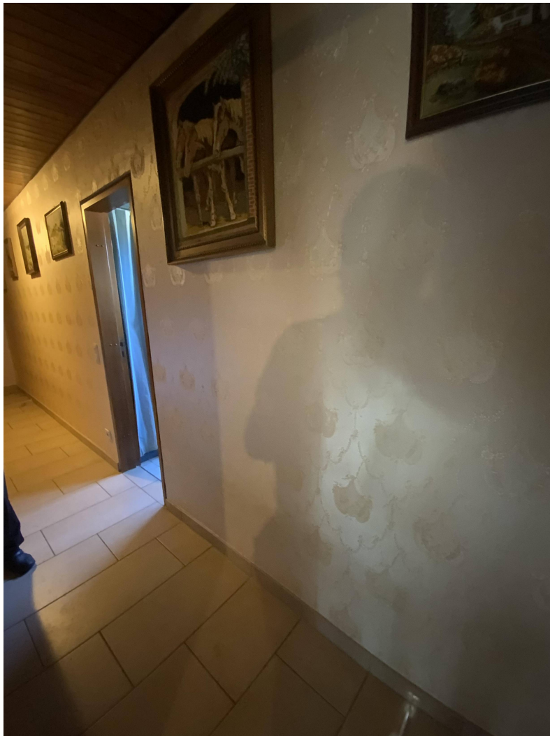
Wand wird noch geöffnet
